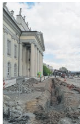
Kaum beachtet: Bauarbeiten vor dem Fridericianum. FOTO: THOMAS SIEMON
